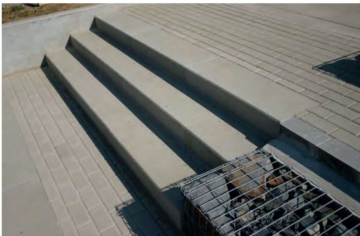
Projet: Lycée à Mersch Dalles en béton: 75 x 50 x 12 cm et 50 x 50 x 12 cm et marches sur mesures. Projekt: Gymnasium in Mersch Betonplatten: 75 x 50 x 12 cm und 50 x 50 x 12 cm und Stufen als Massanfertigung.
