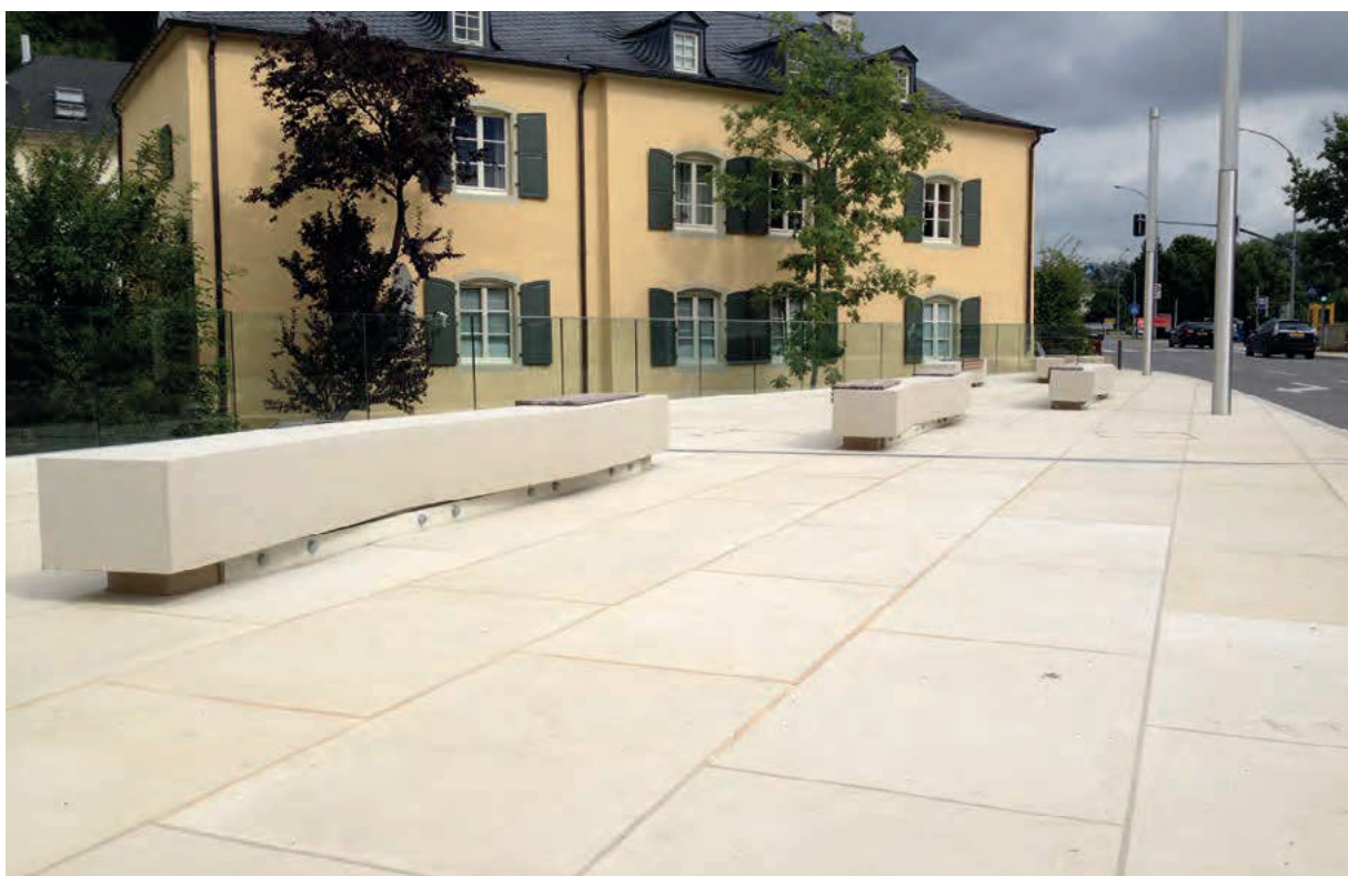
Projet: Centre de Hesperange Dalles en béton avec le relief de Hesperange: 136 x 84 x 12 cm. Projekt: Zentrum in Hesperange Betonplatten mit Oberflächengestaltung von Hesperange: 136 x 84 x 12 cm.
