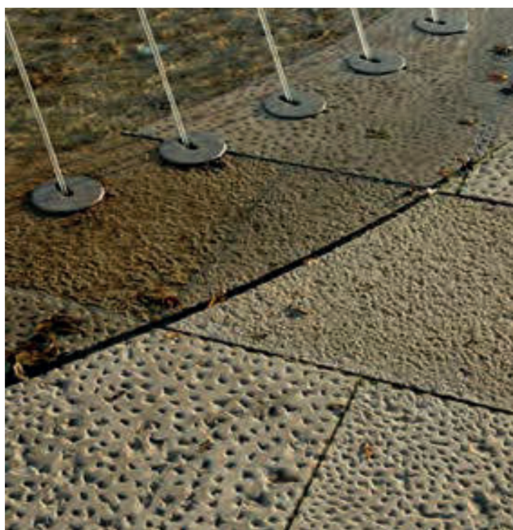
Projet: Nouveau Théâtre à Luxembourg - Limpertsberg Dalles en béton armé (SLW30): 200 x 100 x 14 cm et murs préfabriqués en béton armé Projekt: Neues Theater in Luxembourg - Limpertsberg Platten aus armiertem Beton (SLW30): 200 x 100 x 14 cm und Mauern fabrikfertig aus armiertem Beton.
