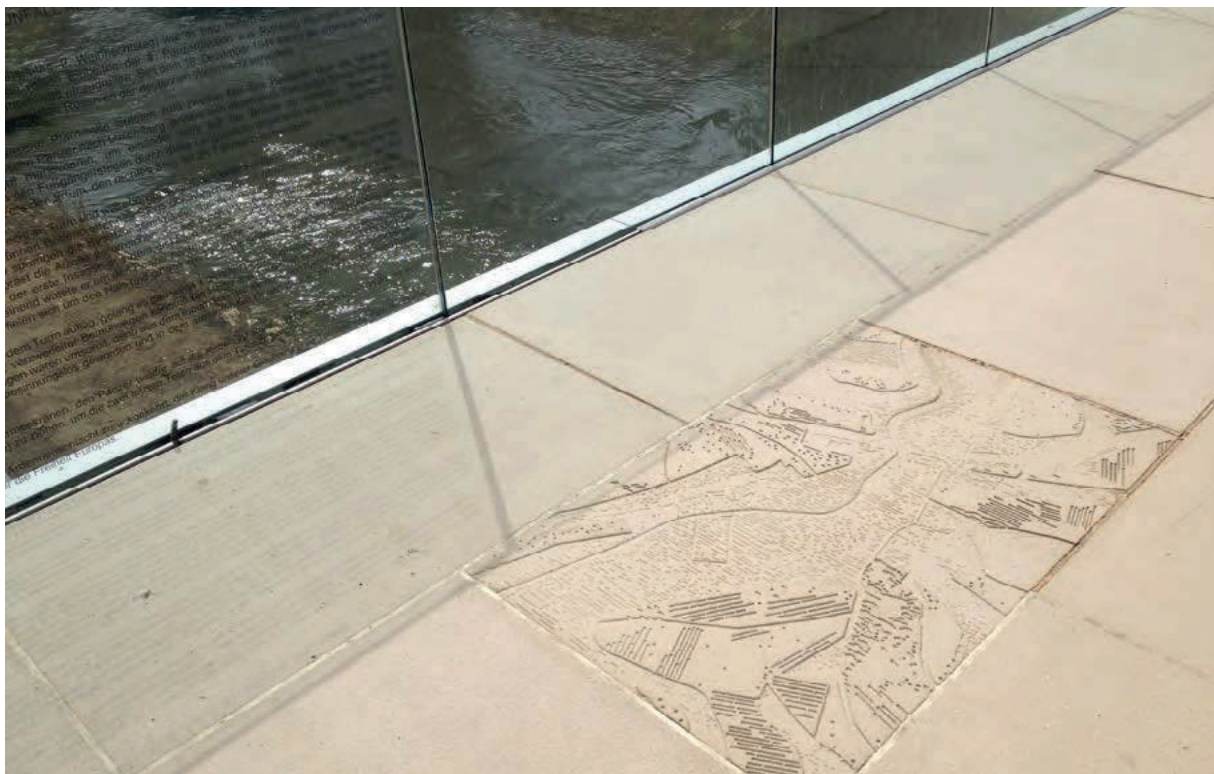
Projet: Centre de Hesperange Dalles en béton avec le relief de Hesperange: 136 x 84 x 12 cm. Projekt: Zentrum in Hesperange Betonplatten mit Oberflächengestaltung von Hesperange: 136 x 84 x 12 cm.
